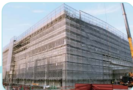
建設中のハドロンホール (2007年)
